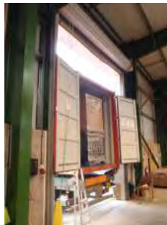
Fig. 06 Warehouse electric door
